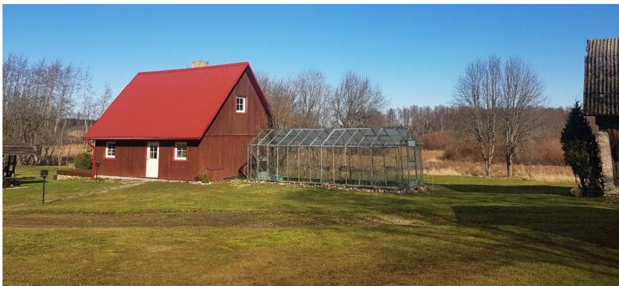
Foto 3. Vaade olemasoleva talu õue elamu peauksest.
