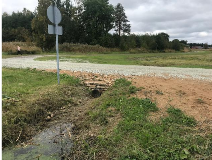
Foto 4.6. Truup Rannaheina tee ja Põhja tee ristumiskohas. Ekstreemsete mereveetasemete korral sulgevad kohalikud truubi ning nii tekib teetammidega suletud maalapp, kuhu merevesi ei pääse. Üle tee on Põhja tee 2 kinnistu. 21.09.2022.
