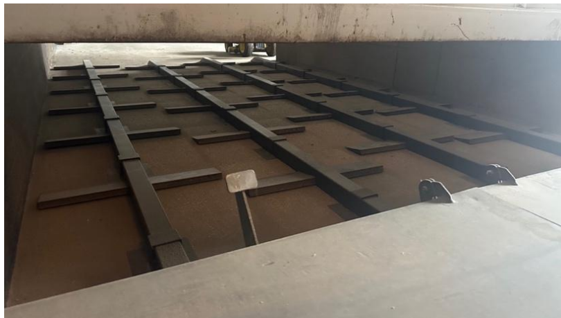
Joonis 6. Kuusalu katlamaja hakkpuidu rooplattidega laopõhi
